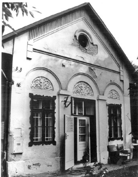
Erzsébet királyné útja 27/A – Zugló ceglédi vasútvonalon kívüli legrégebbi épülete
